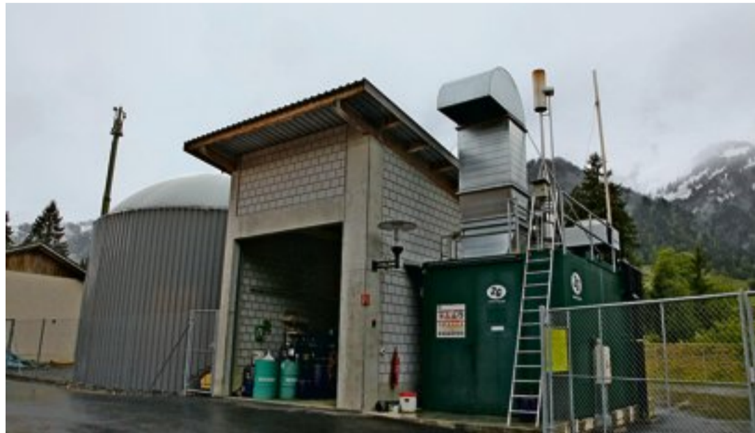
Das Betriebsgebäude der Frutiger Biogasanlage.
